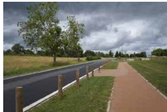
Amélioration de l'accès et du stationnement au Gour de Tazenat
