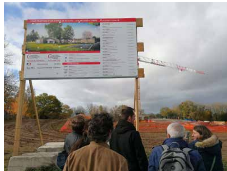
Chantier du nouvel EHPAD des Ancizes
